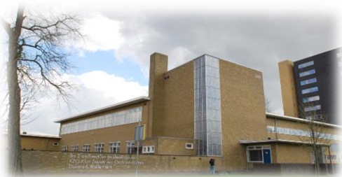
Nieuwe bestuurskantoor Ringbaan Oost 240
